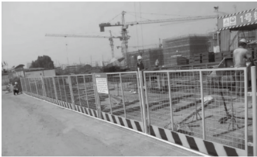
图 9-2 施工现场临时安全隔离设施
